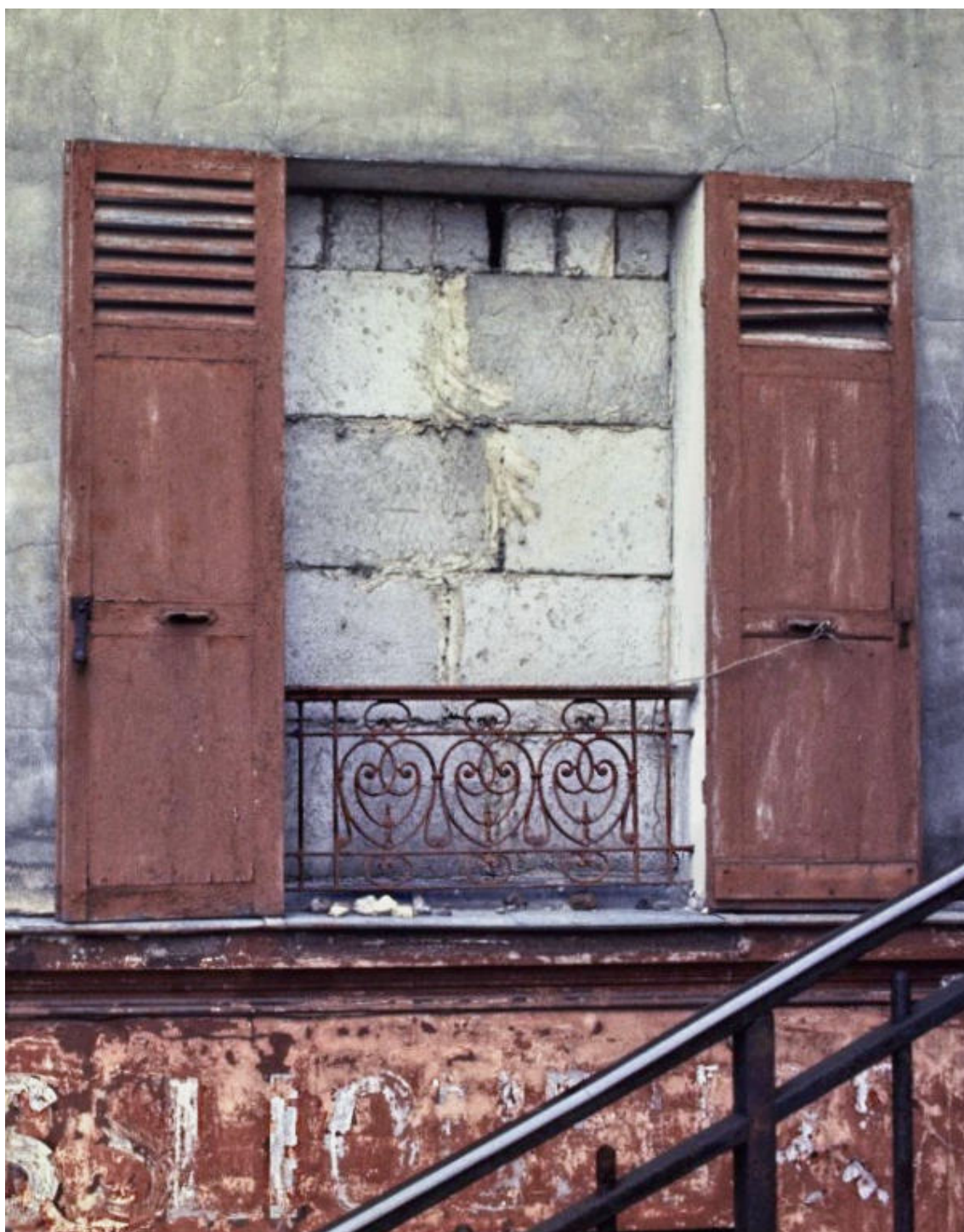
n° 53-55, rue Vilin 1 er étage, contrevents bois semi-persiennés, appui de fenêtre en fer forgé
