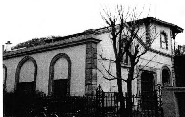
Ancienne gare de la rue d'Avron, aujourd'hui
